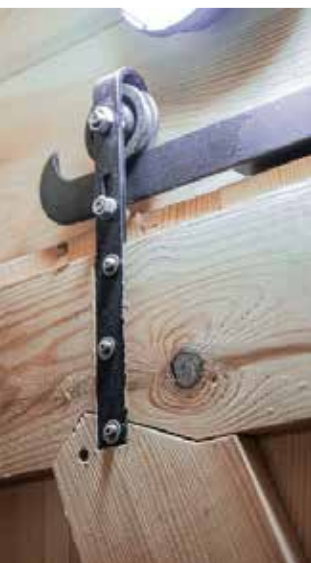
Rolltüren sparen Platz. Die Laufschienen sind selbstgebaut
